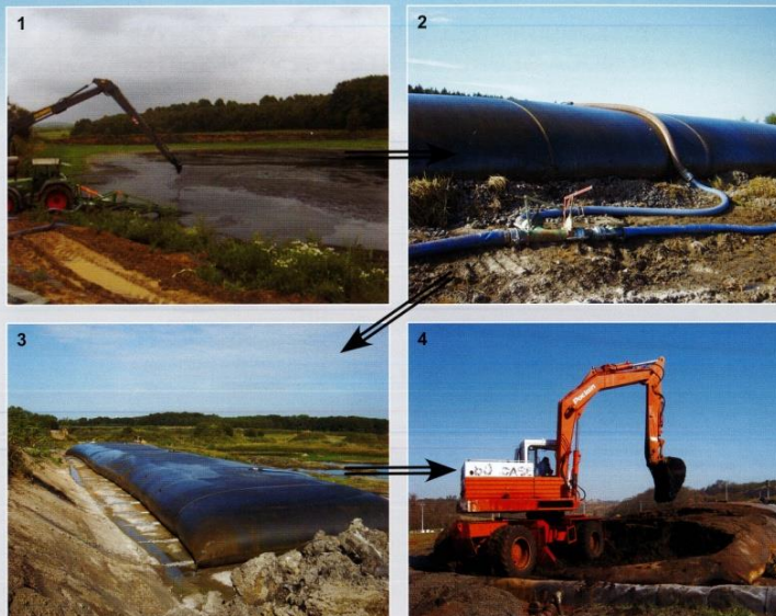
Poszczególne etapy odprowadzania osadów w stanie płynnym
